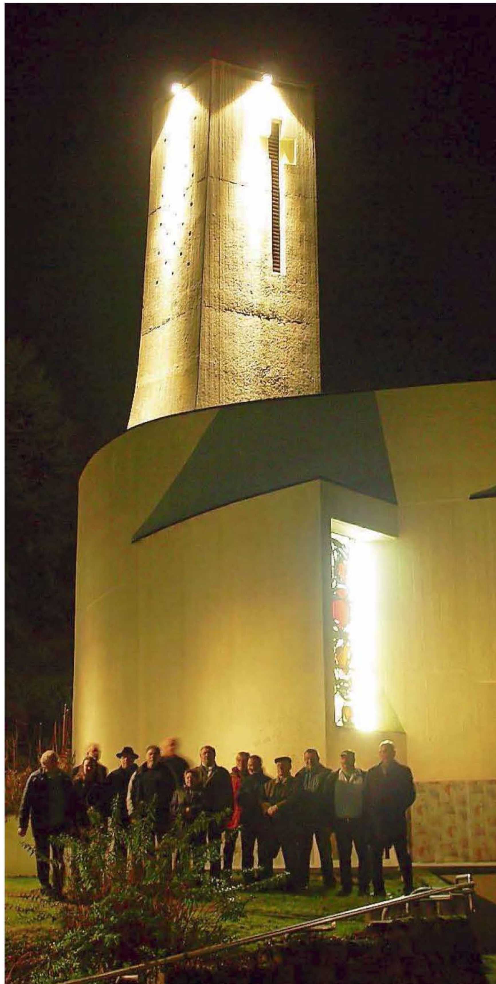
In neuem Licht erstrahlt die evangelische Kirche in Hangard. Das Baudenkmal wurde 1966 erbaut. FOTO: WILLI HIEGEL
